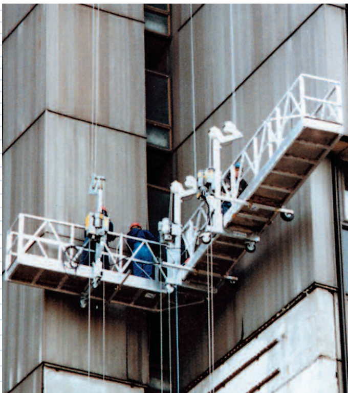
avec une commande on peut operer 1, 2 ou 3 treuils
