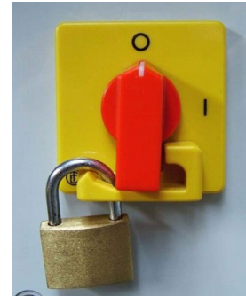
Abb. 43: Hauptschalter gesichert
