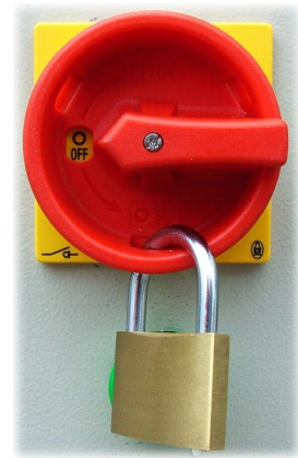
Ill. 44 – Interrupteur principal verrouillé
