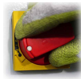
III. 61 – Réinitialisation du disjoncteur-protecteur
