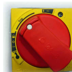
III. 61 – Disjoncteur-protecteur déclenché
