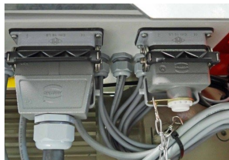
III. 77 – Fiche isolante de la commande des essais de freinage
