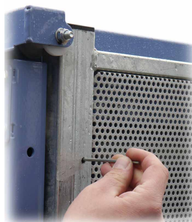
Abb. 17: Notentriegelung vor dem Fahrkorb
