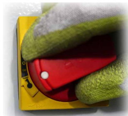
Abb. 61 Leistungsschalter zurücksetzen
