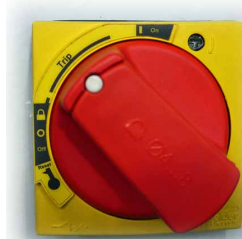
Abb. 60 Leistungsschalter ausgelöst
