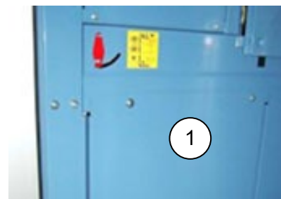
Abb. 43: Abdeckblech für Schaltkasten im Fahrkorb
