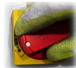
Abb. 62 Leistungsschalter zurücksetzen
