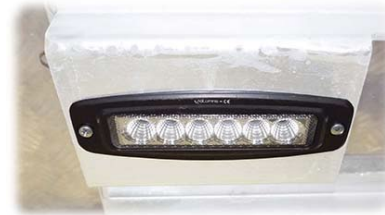
Abb. 41: Fahrkorbbeleuchtung
