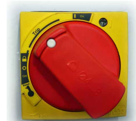
Abb. 61 Leistungsschalter ausgelöst
