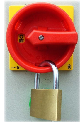
Abb. 62: Hauptschalter gesichert
