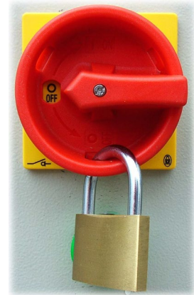
Abb. 50 Hauptschalter gesichert
