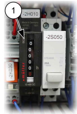
Abb. 55: Betriebsstundenzähler
